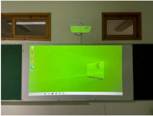
Foto 6 - Instalação de projetores
